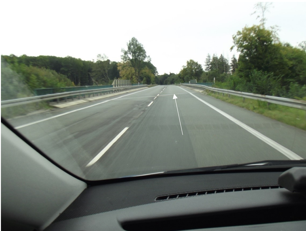
10. L828 über Brückenbauwerk Deutsche Bundesbahn (BW4319514)
