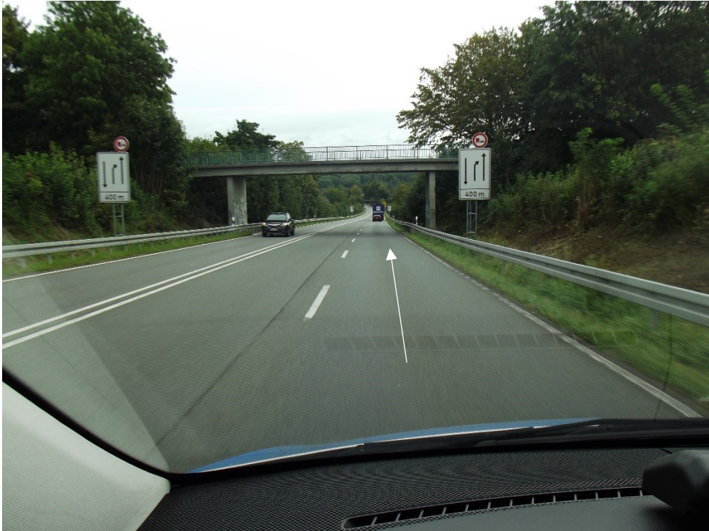
3. B64, Durchfahrt unter Brücke „Dionysiusstraße“
