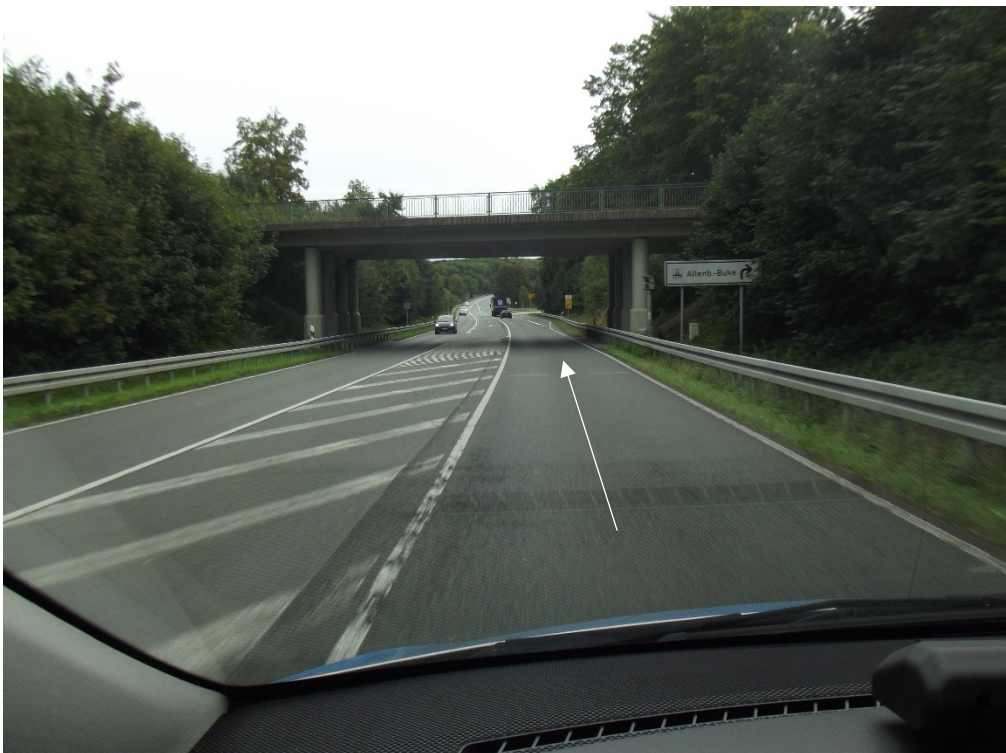
4. B64, Durchfahrt unter Brücke „Schwaneyer Straße“ (L828)
